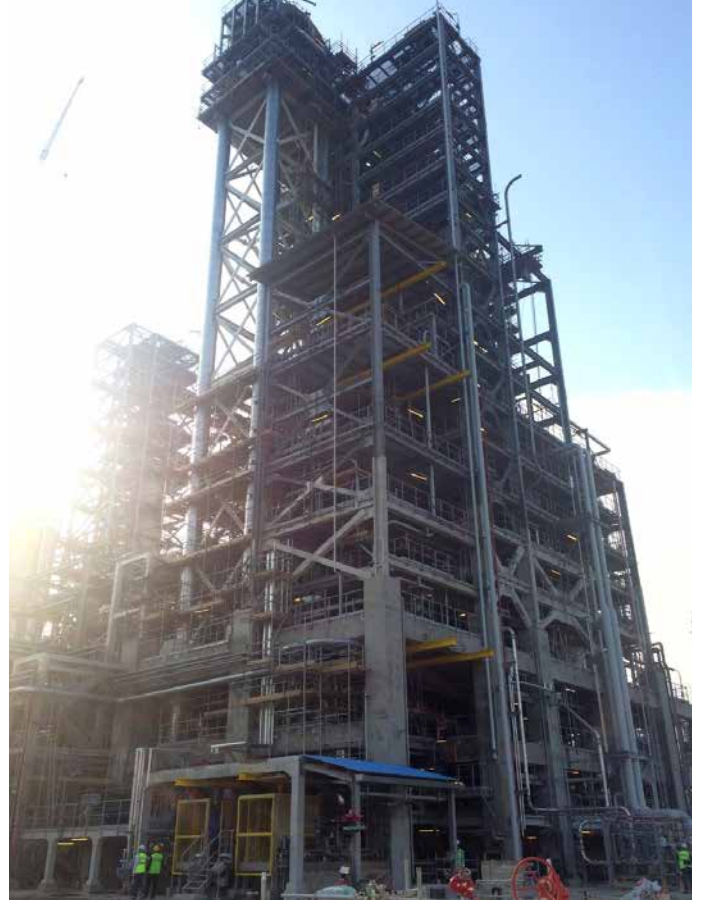
YSPE zavodu: Polimerləşdirmə qurğusu. Kabel tavalarının qapaqlarının quraşdırılması və boru sistemlərinin izolyasiya işləri davam etmişdir.
