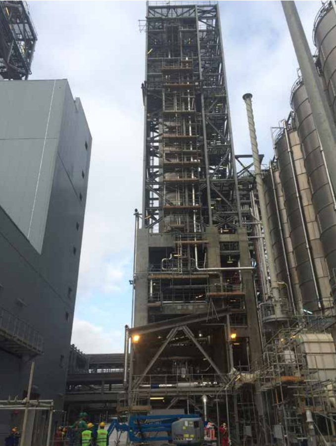
YSPE zavodu: Orqanoleptik qurğu/Tullantı sularının təmizlənməsi qurğusu. Boru sistemlərinin quraşdırılması davam etmişdir
