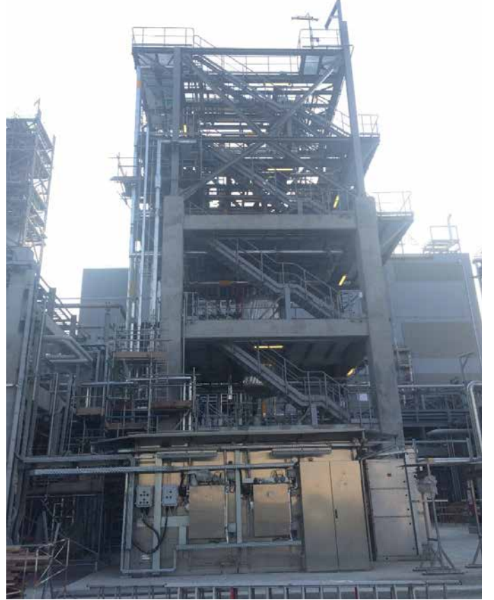
YSPE zavodu: Aşağı təzyiqli əridicilərin rekuperasiyası. Boru sistemlərinin izolyasiyası və rəngsazlıq işləri davam etmişdir
