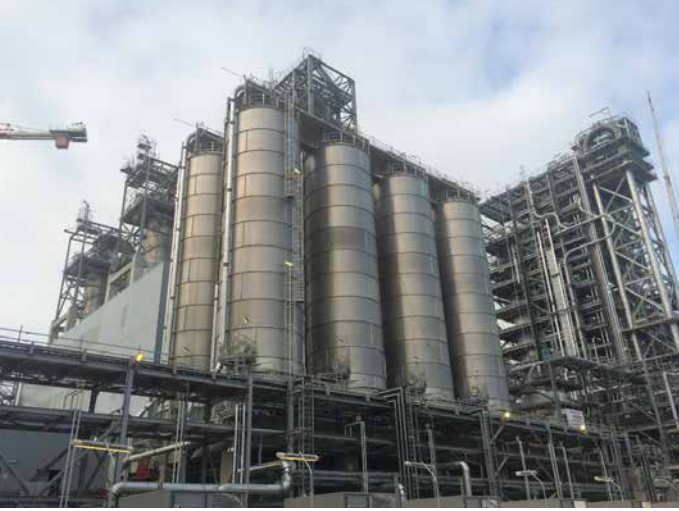
YSPE zavodu: Qarışdırıcı siloslar. Boru sistemlərinin izolyasiya işləri davam etmişdir
