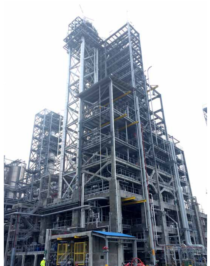
YSPE zavodu: Polimerləşdirmə qurğusu. Natamam işlərin yerinə yetirilməsi davam etmişdir
