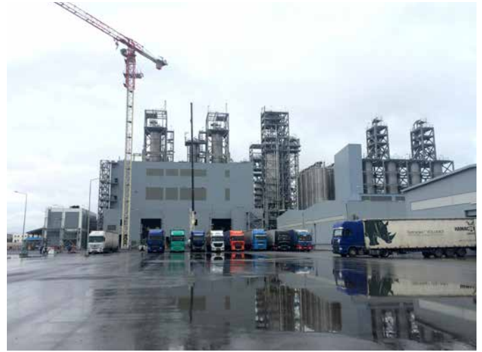
YSPE zavodu: Ekstruziya qurğusu. Liftlərin istismara qəbulu başlamalıdır; natamam işlərin yerinə yetirilməsi davam etmişdir
