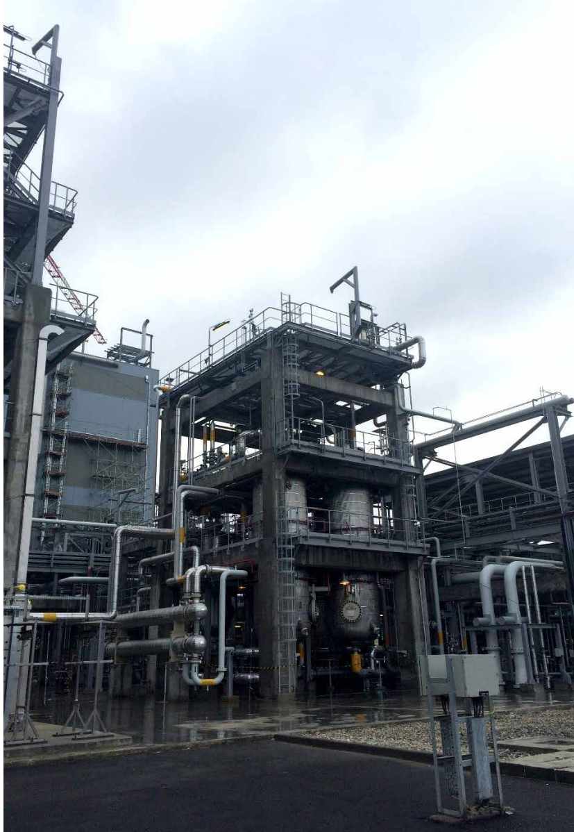
YSPE zavodu: Etilenin təmizlənməsi. Natamam işlərin yerinə yetirilməsi davam etmişdir
