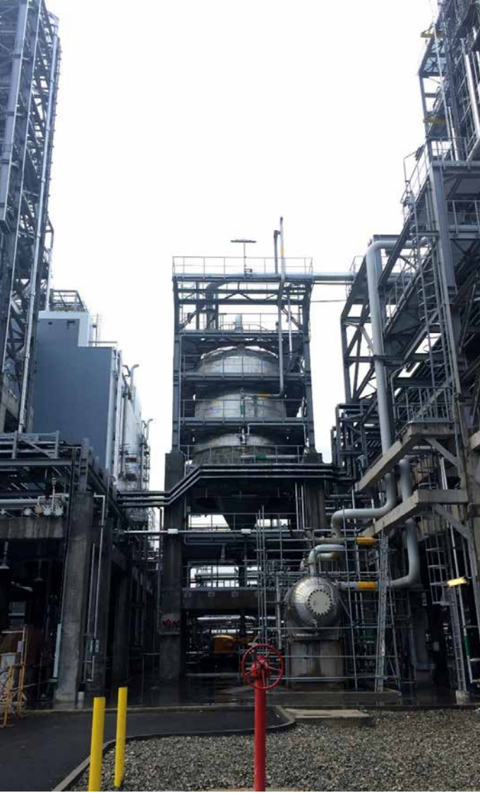
YSPE zavodu: Reaktorun boşaltma rezervuarı. Natamam işlerin yerine yetirilmesi devam etmiştir
