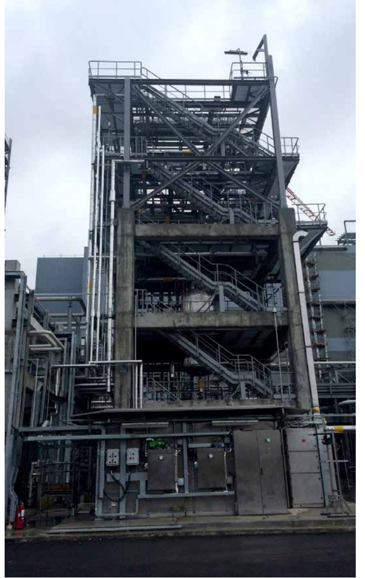
YSPE zavodu: Aşağı təzyiqli ərیدicilerin rekuperasiyası. Natamam işlerin yerine yetirilmesi devam etmiştir
