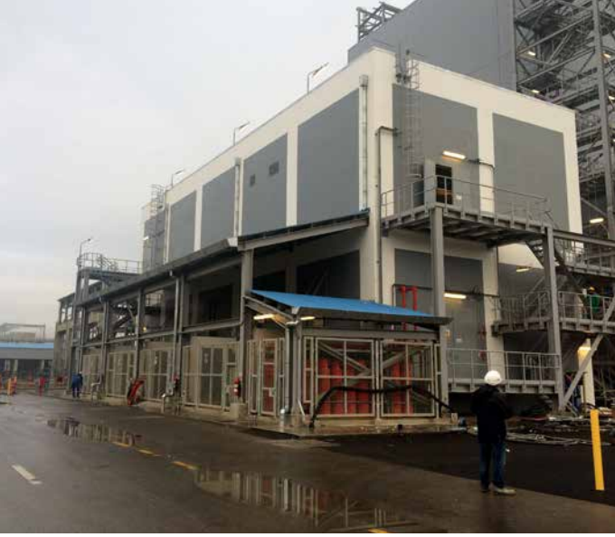
YSPE zavodu: Elektrik yarımstansiyası. Natamam işlerin yerine yetirilmesi devam etmiştir
