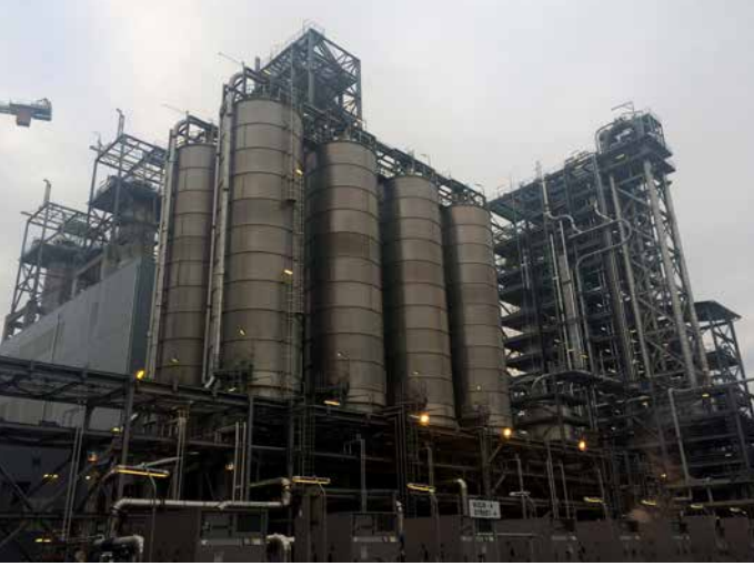
YSPE zavodu: Qarışdırıcı siloslar. Natamam işlərin yerinə yetirilməsi davam etmişdir
