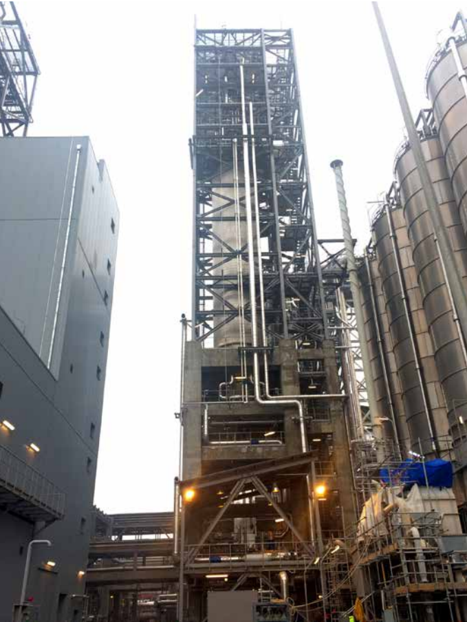
YSPE zavodu: Orqanoleptik qurğu/Tullantı sularının təmizlənməsi qurğusu. Natamam işlərin yerinə yetirilməsi davam etmişdir
