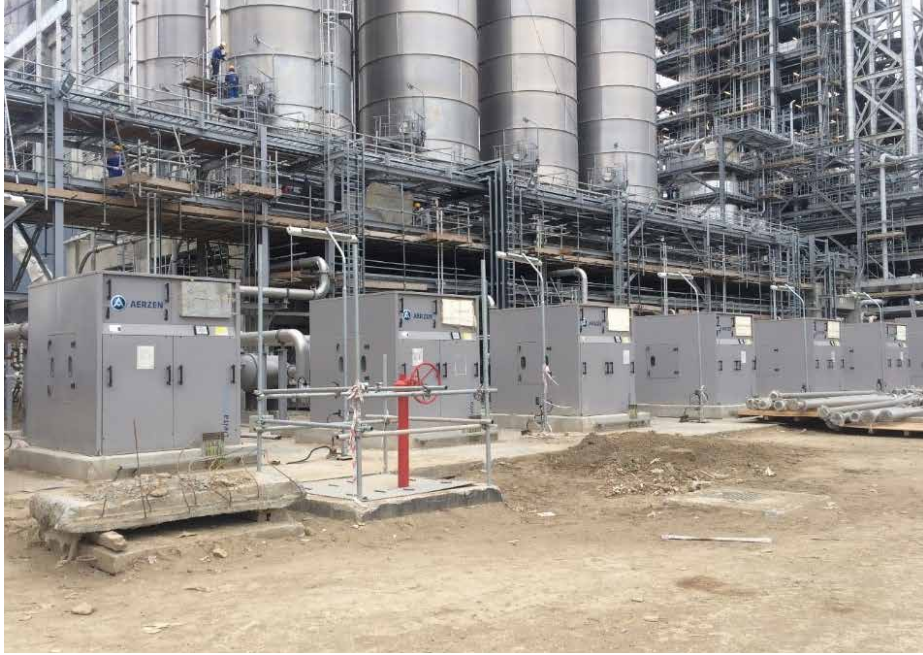
YSPE zavodu: qranula üfürücü aqreqatın logistika sahəsi.
