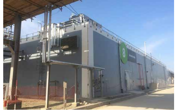
PP zavodu/ MŞ və ÜT: Vahid idarəetmə otağı. Natamam işlər siyahısındakı işlərin başa çatdırılması davam etmişdir
