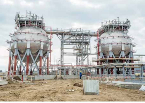
PP zavodu/ Mř ve ŰT: Sferik izobutan rezervuarı. Natamam iřler siyahısındaki iřlerin bařa řatdırılması davam etmiřdir
