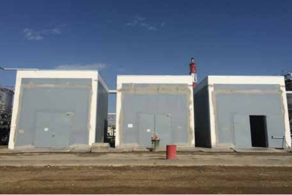
PP zavodu/ MŞ və ÜT: Klapanlar binası.
