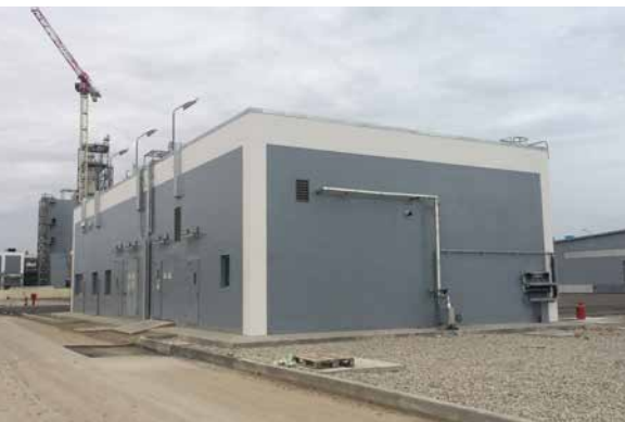
PP zavodu/ MŞ və ÜT: İnzibati bina. Natamam işlər siyahısındakı işlərin başa çatdırılması davam etmişdir
