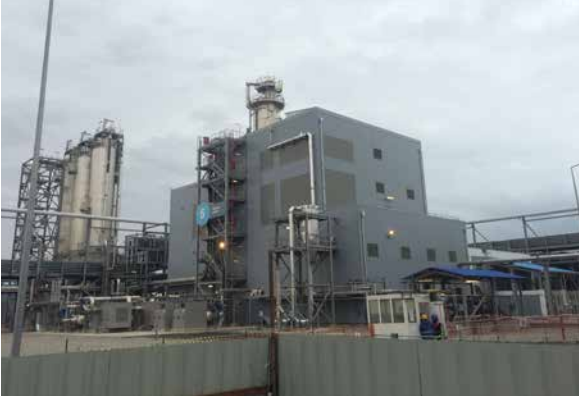
PP zavodu/ MŞ və ÜT: PP – Quru bölmə / Ekstruziya binası. Natamam işlər siyahısındakı işlərin başa çatdırılması davam etmişdir
