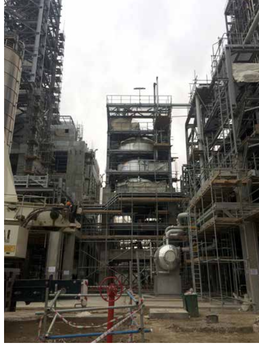
YSPE zavodu: Reaktorun boşaltma rezervuarı. Elektrotexniki işlər davam etmişdir
