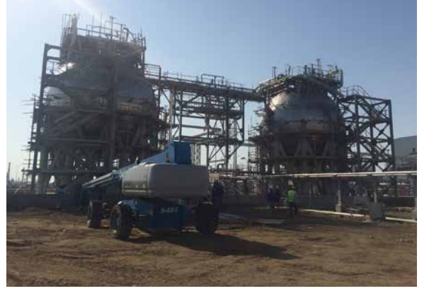
PP zavodu/ Mř ve ŰT: Sferik izobutan rezervuarı. Natamam iřler siyahısındaki iřlerin bařa řatdırılması davam etmiřdir
