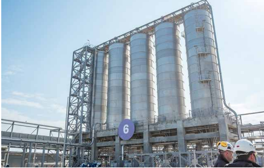
PP zavodu/ MŞ və ÜT: Homogenləşdirmə qurğusu / Qarışdırıcı silolar. Natamam işlər siyahısındakı işlərin başa çatdırılması davam etmişdir
