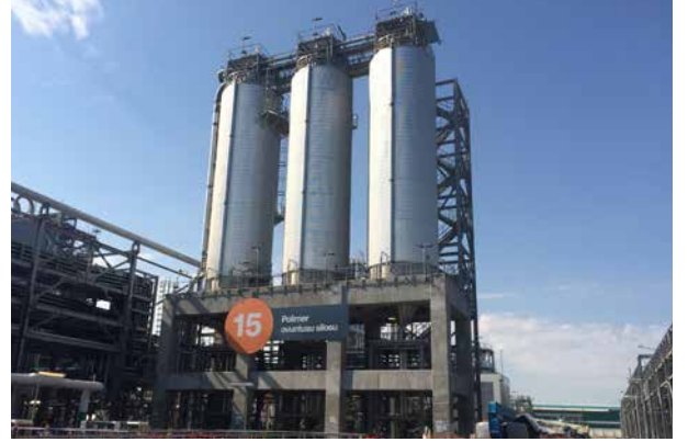
PP zavodu/ MŞ və ÜT: PP- Quru bölmə / PP ovuntusu siloları. Natamam işlər siyahısındakı işlərin başa çatdırılması davam etmişdir
