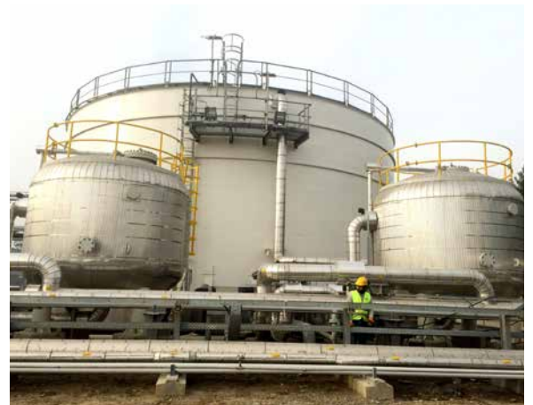
PP zavodu/ MŞ və ÜT: Homogenləşdirmə qurğusu / Qarışdırıcı silolar. Buraxılış-sazlama işləri davam etmişdir
