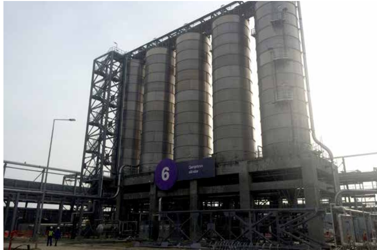
PP zavodu/ MŞ və ÜT: Homogenləşdirmə qurğusu / Qarışdırıcı silolar. Buraxılış-sazlama işləri davam etmişdir
