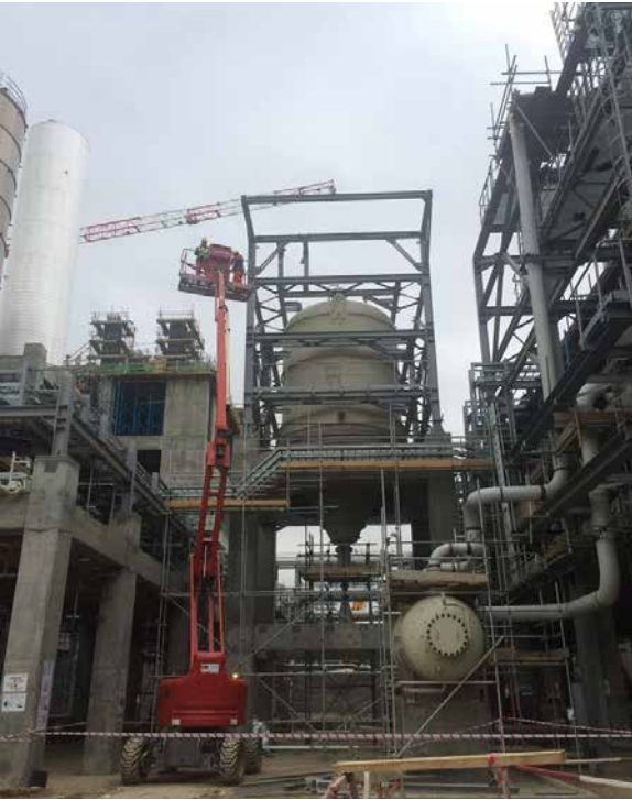
YSPE zavodu: Reaktorların boşaltma rezervuarı. Elektrotexniki işlər davam edir
