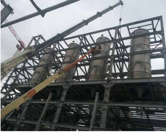
YSPE zavodu: Torbalama və qablaşdırma. Metal konstruksiyaların quraşdırılması davam edir
