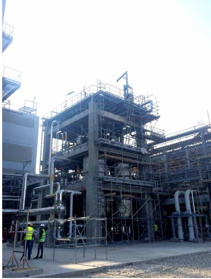
YSPE zavodu: Aşağı təzyiqli ərıdıcılərın rekuperasıyası. Boru sistemlərinin izolyasıyası və rəngsazlıq işləri davam etmişdir
