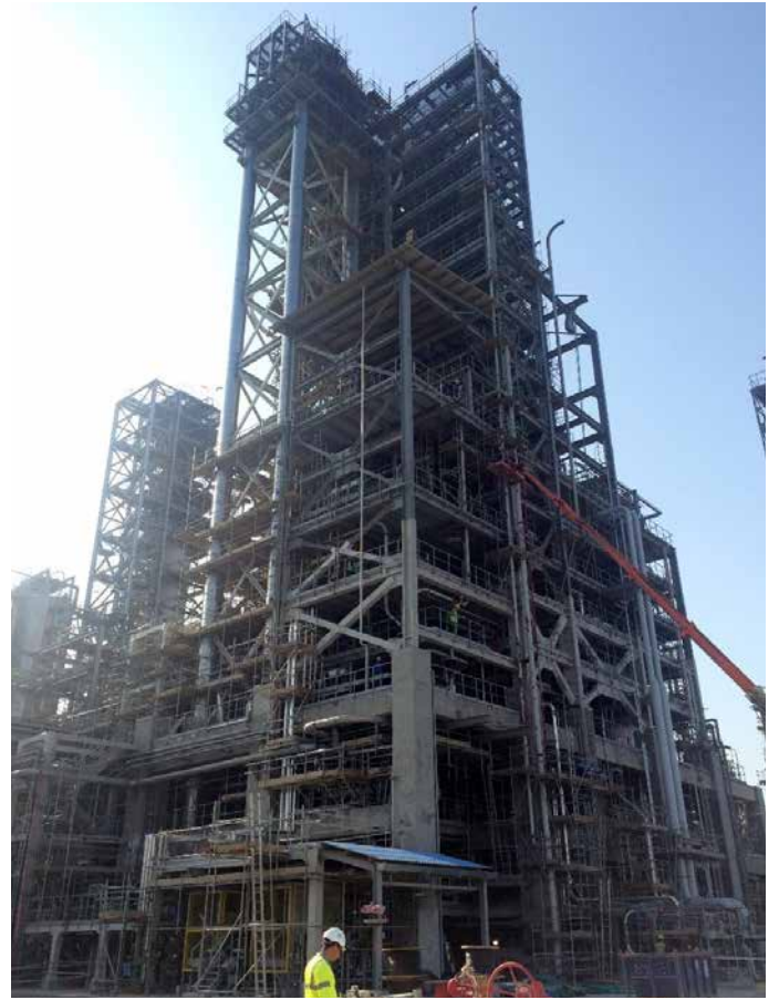
YSPE zavodu: Polimerləşdirmə qurğusu. Konstruksiyaların yanğından mühafizə örtüyü çəkilmişdir. Boru sistemlərinin izolyasiyası davam etmişdir
