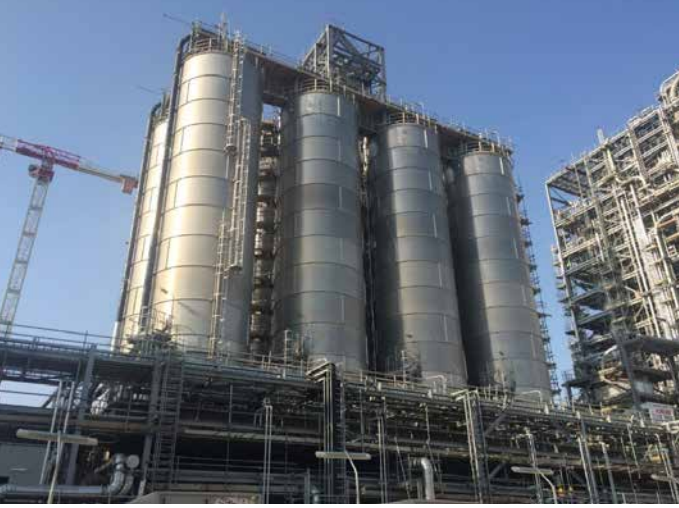
YSPE zavodu: Qarışdırıcı siloslar. Boru sistemlərinin quraşdırılması davam etmişdir
