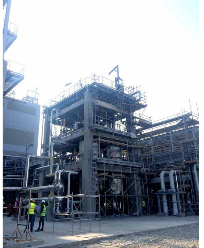
YSPE zavodu: Aşağı təzyiqli əridicilərin rekuperasiyası. Boru sistemlərinin izolyasiyası və rəngsəzliq işləri davam etmişdir
