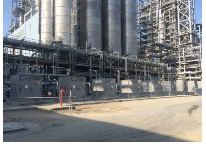
YSPE zavodu: qranula üfürücü aqreqatın logistika sahəsi. Boru sistemlərinin izolyasiyası davam etmişdir
