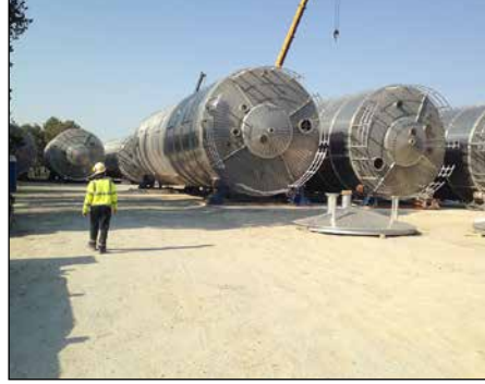
YSPE zavodu: Bir ay ərzində 8 qarışdırıcı silos quraşdırıldı
