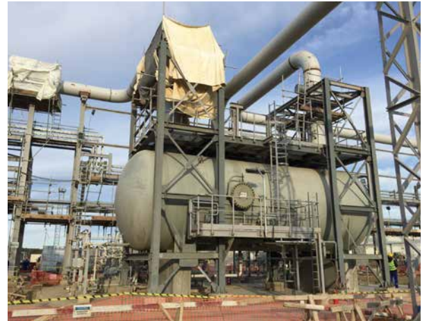
PP zavodu/ MŞ və ÜT: Məşəl separatoru. Boruların sınaqdan keçirilməsi, elektrotexniki işlər və NÖC-lərin quraşdırılması işləri davam etmişdir
