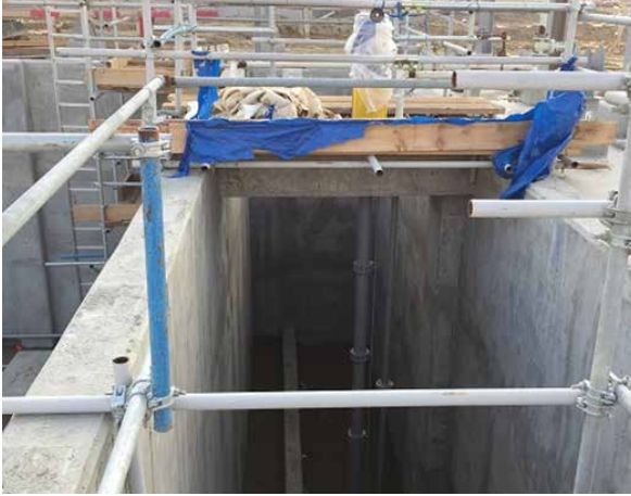
PP zavodu/ MŞ və ÜT: İzobutan toplama hovuzu. Boruçəkmə işləri davam etmişdir. Elektrotexniki və NÖC işləri davam etmişdir
