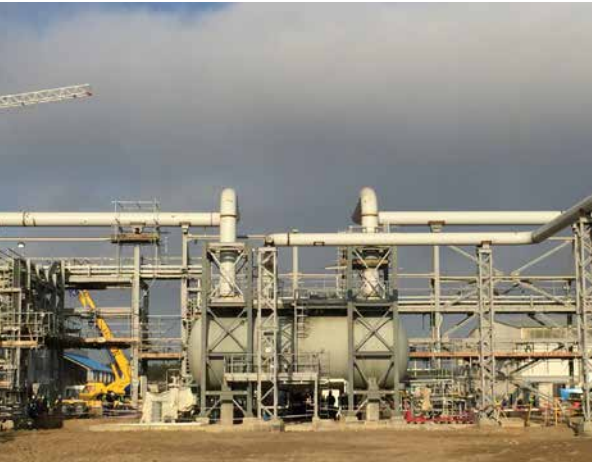
PP zavodu/ MŞ və ÜT: Məşəl separatoru. Boruların sınaqdan keçirilməsi, elektrotexniki işlər və NÖC-lərin quraşdırılması işləri davam etmişdir
