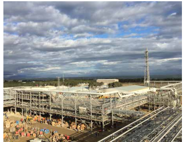
PP zavodu/ MŞ və ÜT: Birləşdirici boru estakadaları. Boruların quraşdırılması davam etmişdir. Kabellərin çəkilməsi davam etmişdir
