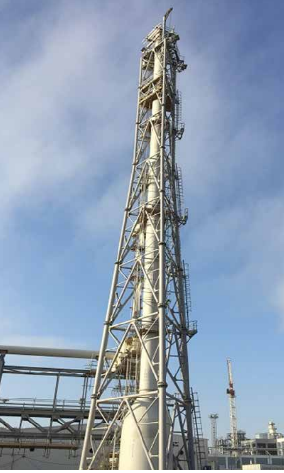
PP zavodu/ MŞ və ÜT: Məşəl bacası. İstismara verilme başına çatmışdır
