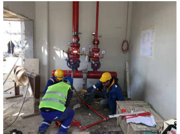
PP zavodu/ MŞ və ÜT: Klapnlar binası. Klapnların və boruların quraşdırılması davam etmişdir. Fasadda rəngsəzlik işlərinin əksər hissəsi başa çatmışdır
