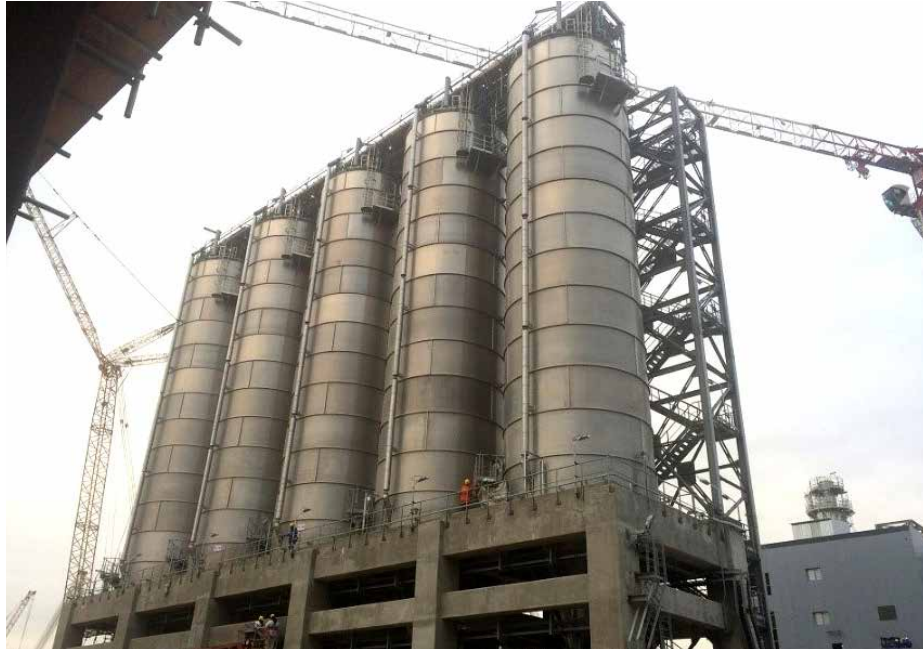
PP zavodu/ MŞ və ÜT: Homogenləşdirmə qurğusu / Qarışdırıcı siloslar. Buraxılış-sazlama işləri davam etmişdir
