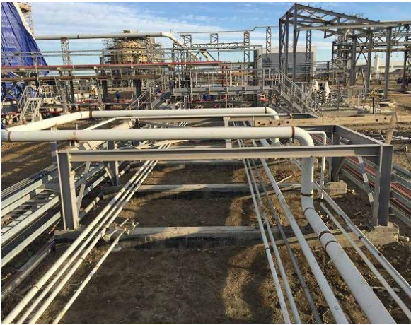
PP zavodu/ MŞ və ÜT: Boru altı şpallar. Boruların və kabel tavalarnın quraşdırılması davam etmişdir. Kabellərin çəkilməsi davam etmişdir
