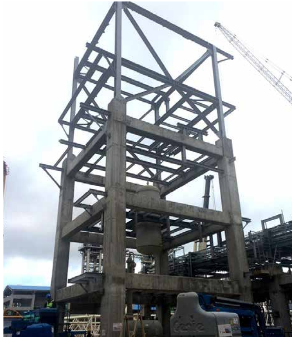
YSPE zavodu: Aşağı təzyiqli əridicilərin çıxarılması. Metal konstruksiyaların quraşdırılması davam etmişdir. Döşənmə işləri başa çatmışdır
