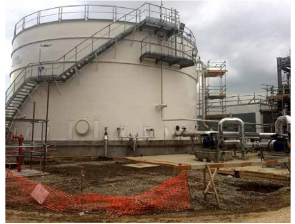
PP zavodu/ MŞ və ÜT: Homogenləşdirmə qurğusu / Qarışdırıcı siloslar. Buraxılış-sazlama işləri davam etmişdir
