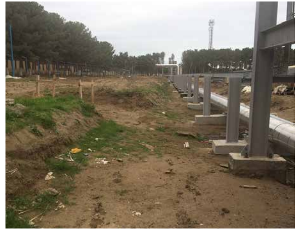
PP zavodu/ MŞ və ÜT: Boru altı şpallar. Boruların və kabel tavalarnın quraşdırılması davam etmişdir. Kabellərin çəkilməsi davam etmişdir
