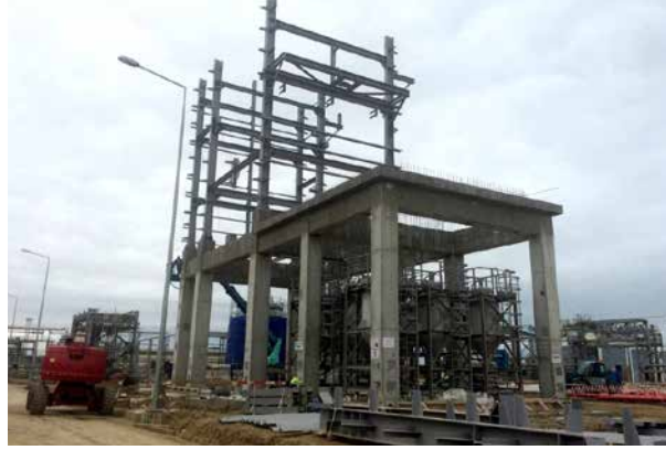
YSPE zavodu: Katalizatorun aktivləşdirilməsi. Metal konstruksiyaların quraşdırılması davam etmişdir
