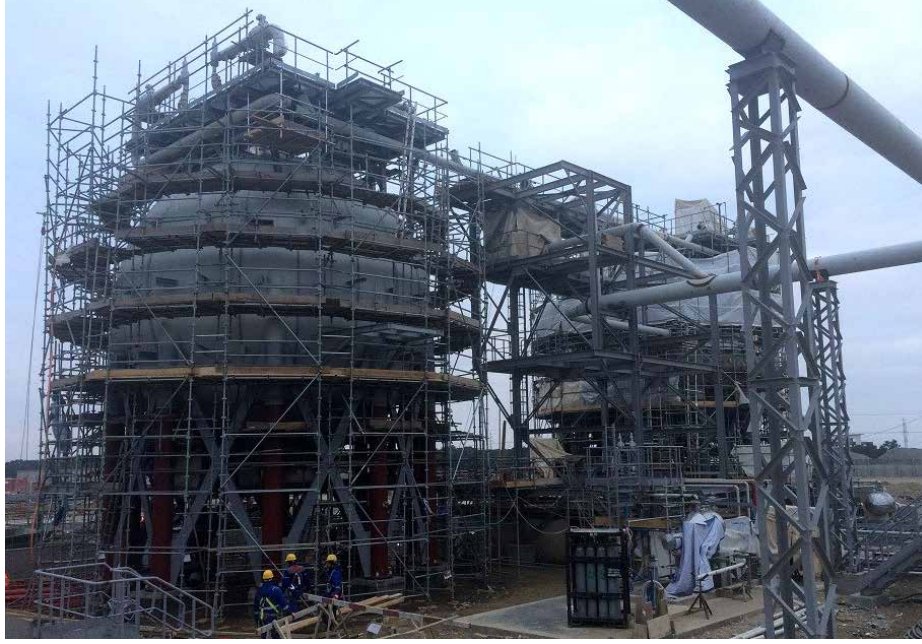
PP zavodu/ MŞ və ÜT: Sferik izobutan rezervuarı. Sprinkler sisteminin quraşdırılması davam etmişdir
