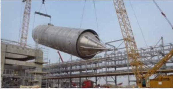
Qarışdırma silosu: Quraşdırma işləri davam edir
