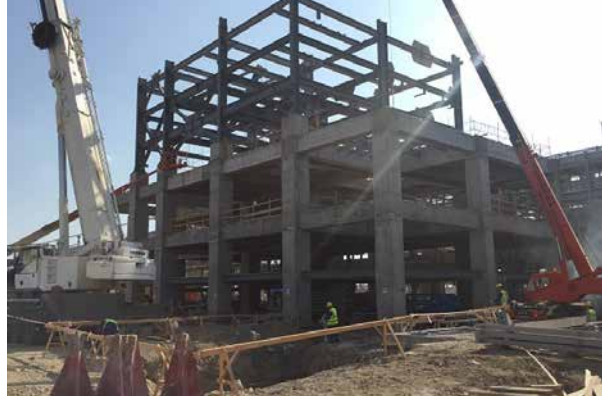
YSPE zavodu: Polimerləşdirmə. Dəmir-beton işləri davam edir. Metal konstruksiyaların quraşdırılması başlamışdır
