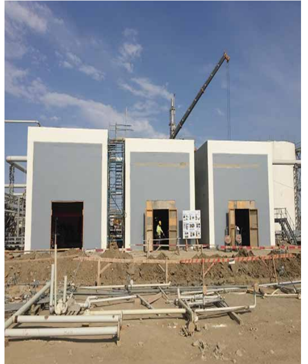
PP zavodu/MŞ və ÜT: Klapanlar yerləşən bina. Klapanların və boruların quraşdırılması davam edir. Fasadda rəngsəzlik işləri gedir
