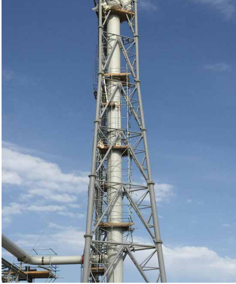
PP zavodu/MŞ və ÜT: Məşəl bacasının qülləsi. Avadanlığın və qüllənin quraşdırılması davam edir
