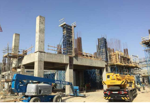
YSPE zavodu: Ekstruziya qurğusu. Dəmir-beton işləri davam edir
