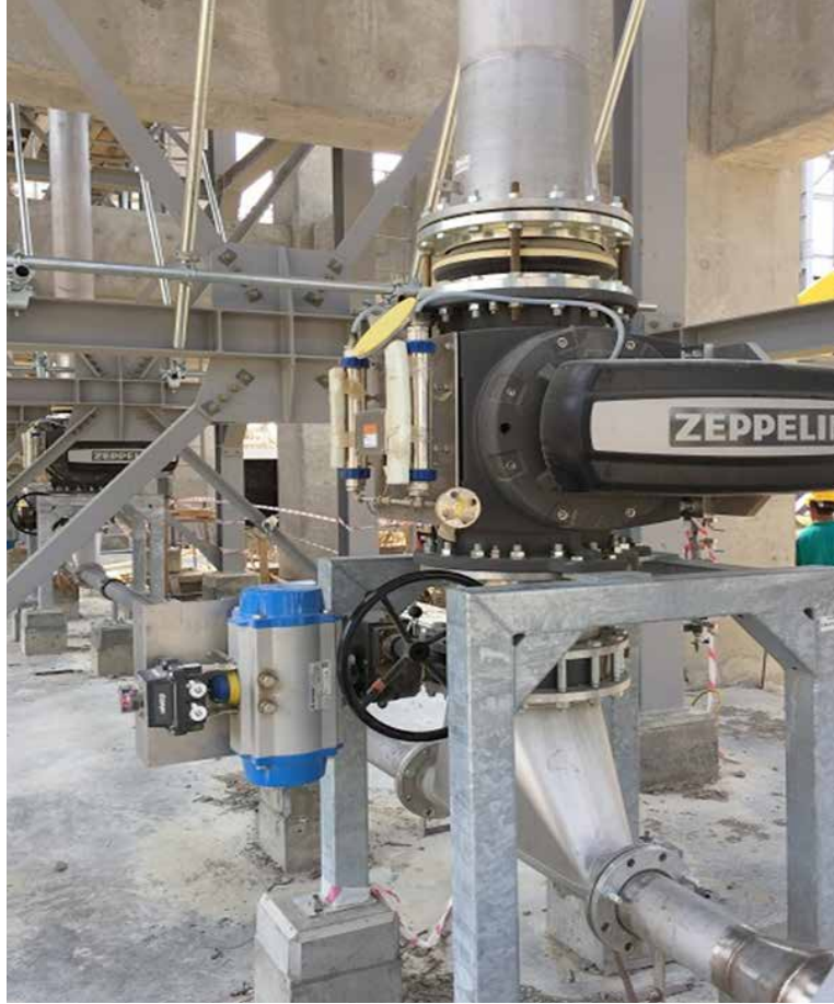
PP zavodu/MŞ və ÜT: Quru PP bölməsi / Poroşok silosu. Avadanlığın və nasosların sazlanması davam edir
