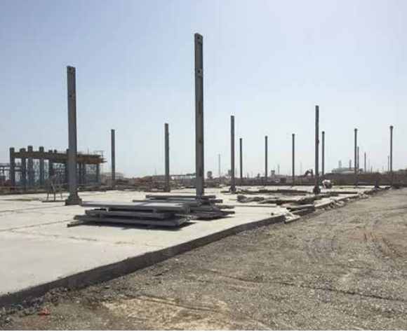
Anbar. Metal sütunların quraşdırılması başa çatmışdır. Fermaların quraşdırılması başlamışdır. Torpaq doldurma işləri başa çatmışdır. Ağır yükə dözümlü döşəmə qurma işləri davam edir. Klapanların yerləşdiyi binada dəmir-beton işləri başa çatmışdır
