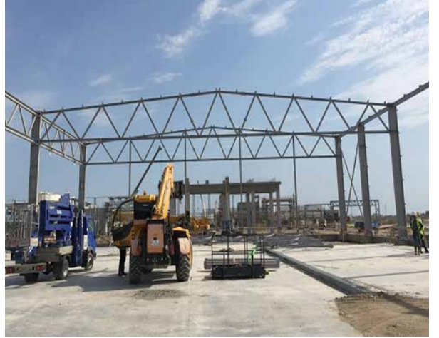
Anbar. Metal sütunların quraşdırılması başa çatmışdır. Fermaların quraşdırılması başlamışdır. Torpaq doldurma işləri başa çatmışdır. Ağır yükə dözümlü döşəmə qurma işləri davam edir. Klapanların yerləşdiyi binada dəmir-beton işləri başa çatmışdır
