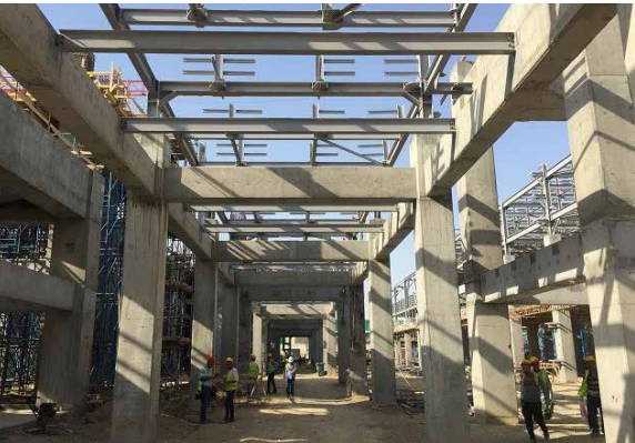
YSPE zavodu: Polimerləşdirmə qurğusunun boru estakadası. Boru dayaqlarının quraşdırılması davam edir
