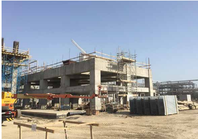
YSPE zavodu: Qarışdırma silosu. Dəmir-beton işləri başa çatmışdır
