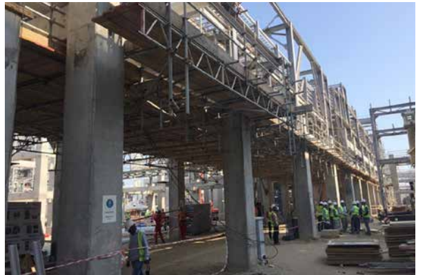
YSPE zavodu: Polimerləşdirmə qurğusunun boru estakadası. Boru dayaqlarının quraşdırılması davam edir
