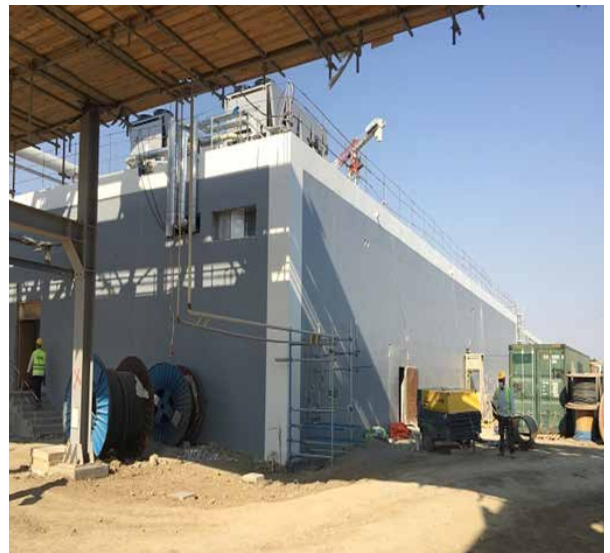
PP zavodu/MŞ və ÜT: Elektrik yarımstansiyası. Şitlərin sınaqdan keçirilməsi davam edir. Kabel tavalarının quraşdırılması və kabel çəkilişi davam edir
