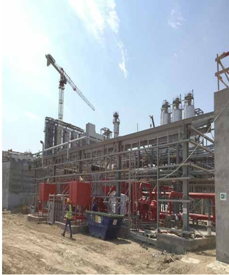
PP zavodu/MŞ və ÜT: Yanğınsöndürmə su hovuzları və nasosxana. Nasosların və boruların quraşdırılması davam edir. Damda izolyasiya işləri davam edir
