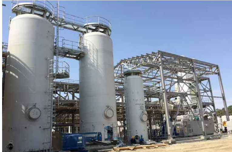
PP zavodu/MŞ və ÜT: Hava /Yüksək təzyiqli azot kondensatı kompressoru stansiyası, anbar və nasosxana. Avadanlığın sazlanması və boruların vahid xətt üzrə düzəldilməsi davam edir
