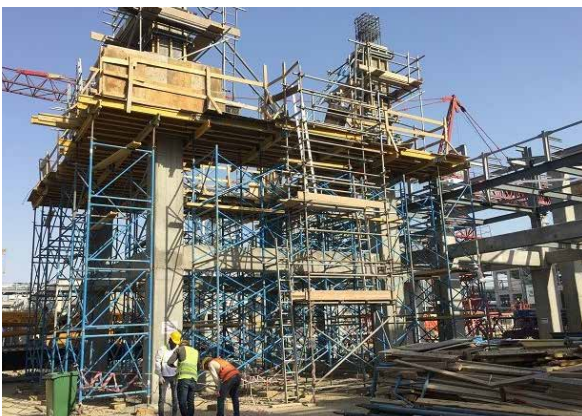
YSPE zavodu: Orqanoleptik bina/tullantı suların təmizlənməsi qurğusu. Dəmir-beton işləri davam edir
