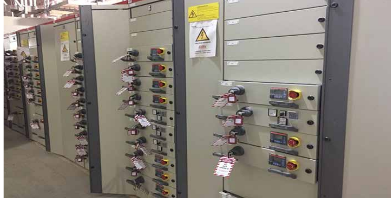
PP zavodu/MŞ və ÜT: Elektrik yarımstansiyası. Şitlərin sınaqdan keçirilməsi davam edir. Kabel tavalarının quraşdırılması və kabel çəkilişi davam edir
