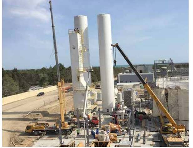
Azot aqreğati. Avadanlığın quraşdırılması başlamışdır
