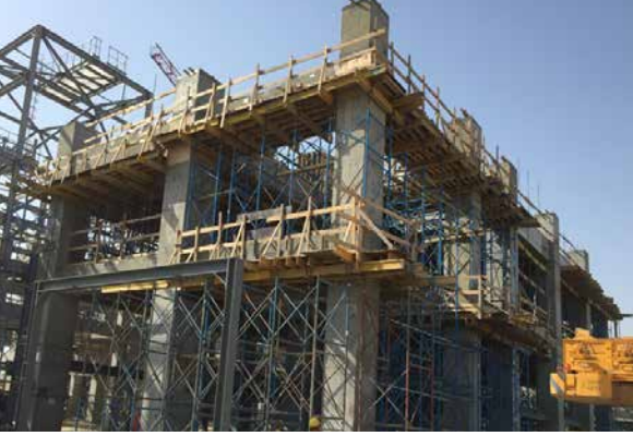
YSPE zavodu: Polimerləşdirmə. Dəmir-beton işləri davam edir. Metal konstruksiyaların quraşdırılması başlamışdır
