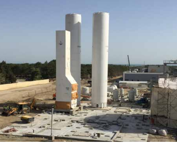
Azot aqreğati. Avadanlığın quraşdırılması başlamışdır
