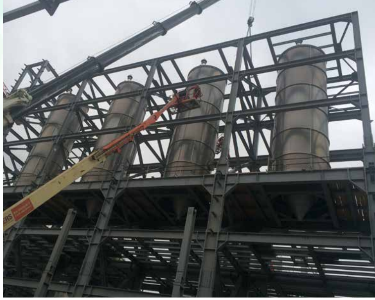
YSPE zavodu: Torbalama və qablaşdırma. Metal konstruksiyaların quraşdırılması davam etmişdir
