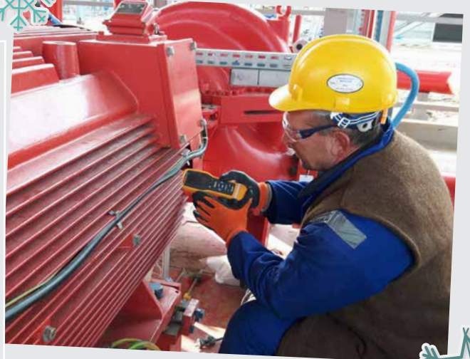
Rotoruna yük qoşulmadan ilk motor sınağı
