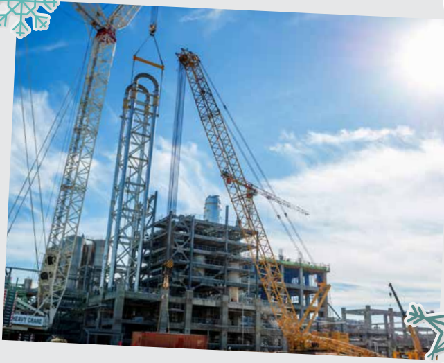
Sirkulyasiya reaktorlarının quraşdırılması
