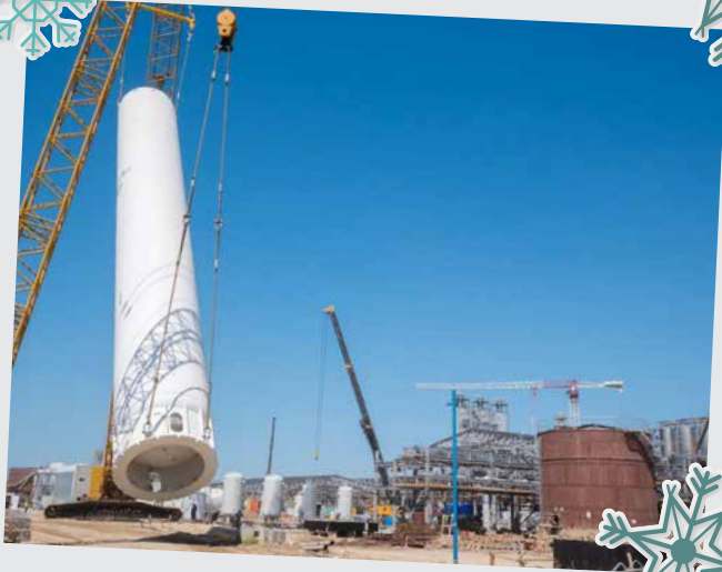
Maye azotun saxlanması və qazlaşdırılması sistemi
