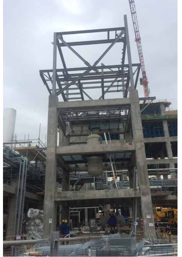
YSPE zavodu: Aşağı təzyiqli əridicilərin çıxarılması. Metal konstruksiyaların quraşdırılması davam etmişdir
